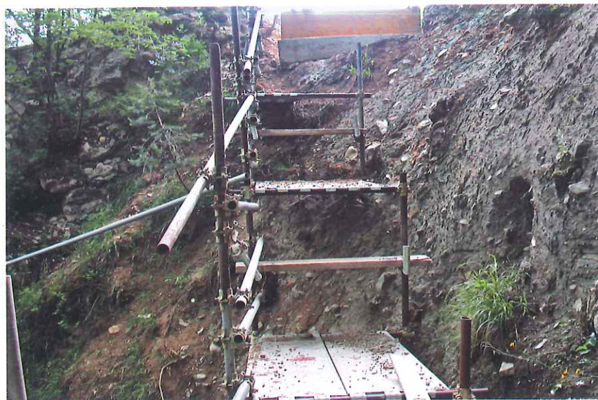
Fig. 5 – Pesciara: lavori di allestimento per la realizzazione della passerella di collegamento tra il nuovo sentiero e l'ingresso dello scavo in galleria. (Foto di R. Zorzin)
