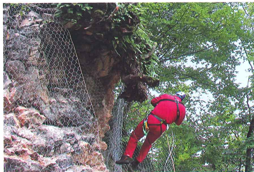
Fig. 6 – Pesciara: posa ed ancoraggio della rete metallica lungo la parete soprastante l'ingresso del nuovo scavo in galleria. (Foto di R. Zorzin)
